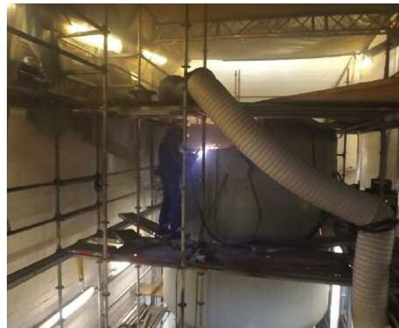
Beim Umbau der Carix-Anlage wurden die Behälter für die Reinwasserentgasung zerlegt...
