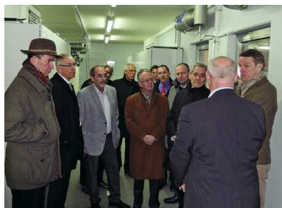
Besichtigung einer Grund- und Quellwasseraufbereitungsanlage.
