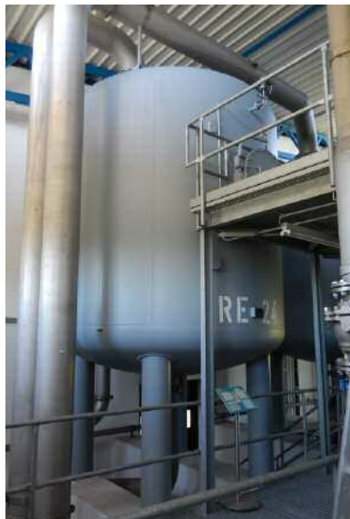
Beim Umbau der Carix-Anlage wurden die Behälter für die Reinwasserentgasung zerlegt...
