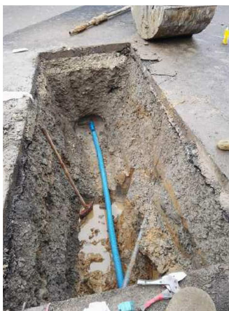
Erneuerung eines Hausanschlusses in der Zeppelinstraße in Schönaich
