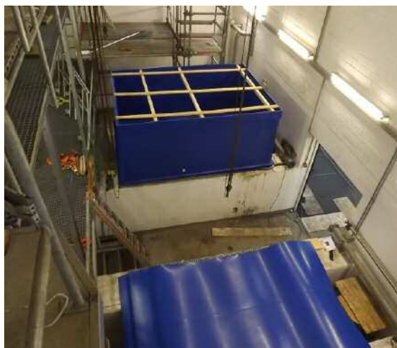
... und durch diese neuen Entgaser ersetzt
