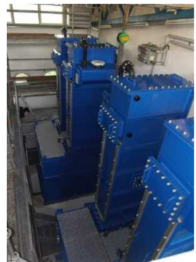
Beim Umbau der Carix-Anlage wurden die Behälter für die Reinwasserentgasung zerlegt...
