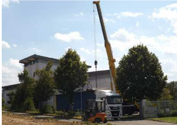
Umbau der Carix-Anlage
